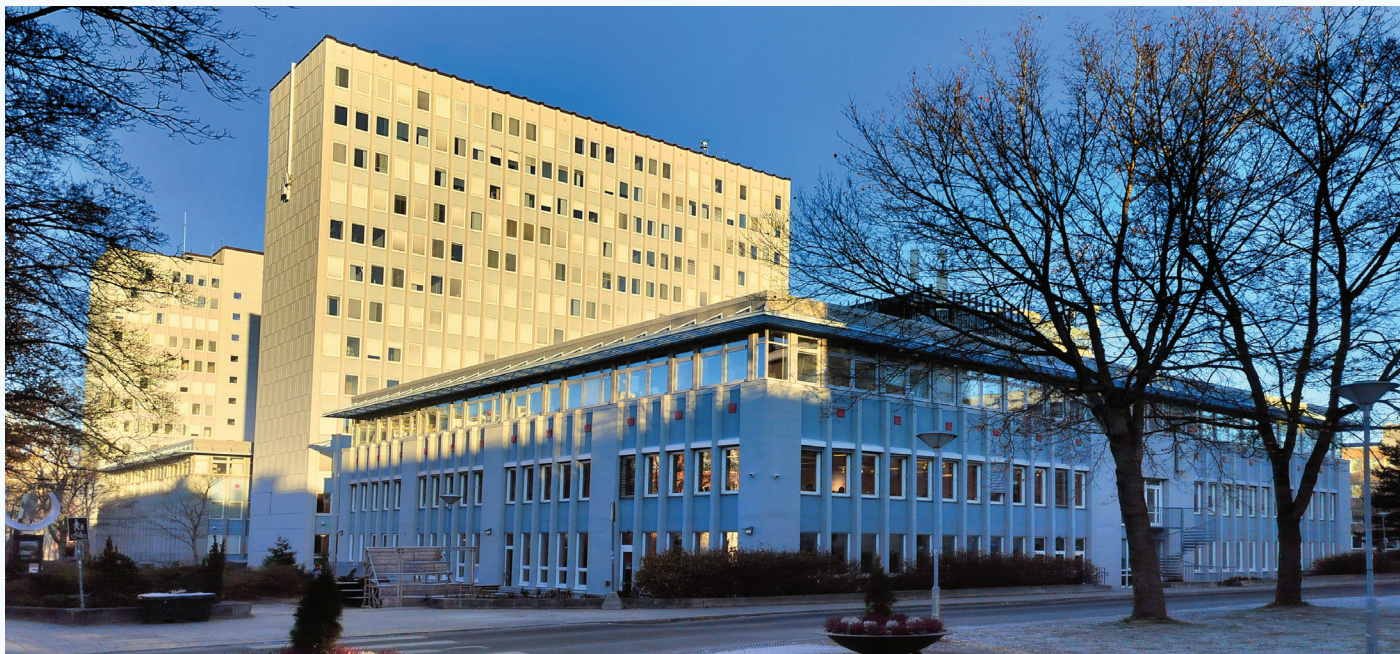
Sentralbygg 1 og 2 på NTNU campus Gløshaugen består av to høyblokker og tre tilknyttede lavblokker. Byggene ble bygd i 1961/68 av prefabrikkerte betongelementer og har et stort energisparingspotensial.
