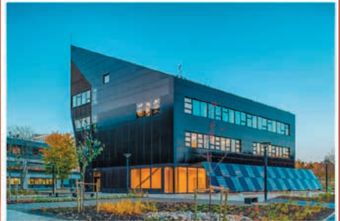
Det nye nullutslippelaboratoriet, ligger på Gløshaugen i Trondheim. Foto: Mathias C. Herzog
